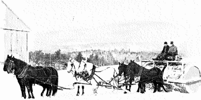
TOP: THE JAFFREY SNOW ROLLER WHICH WAS USED TO ROLL DOWN THE SNOW AFTER A SNOWSTORM. THE PICTURE WAS TAKEN AT THE ARK ABOUT 1912.
